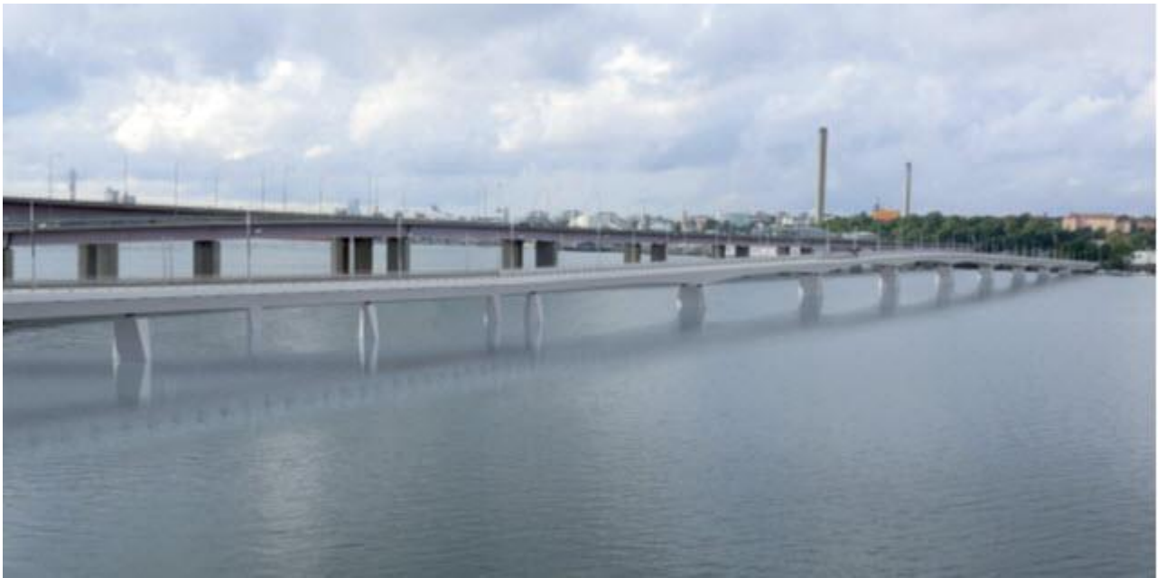
Implenia har fått i uppdrag att bygga Lilla Lidingöbron. (Bild: Implenia)
