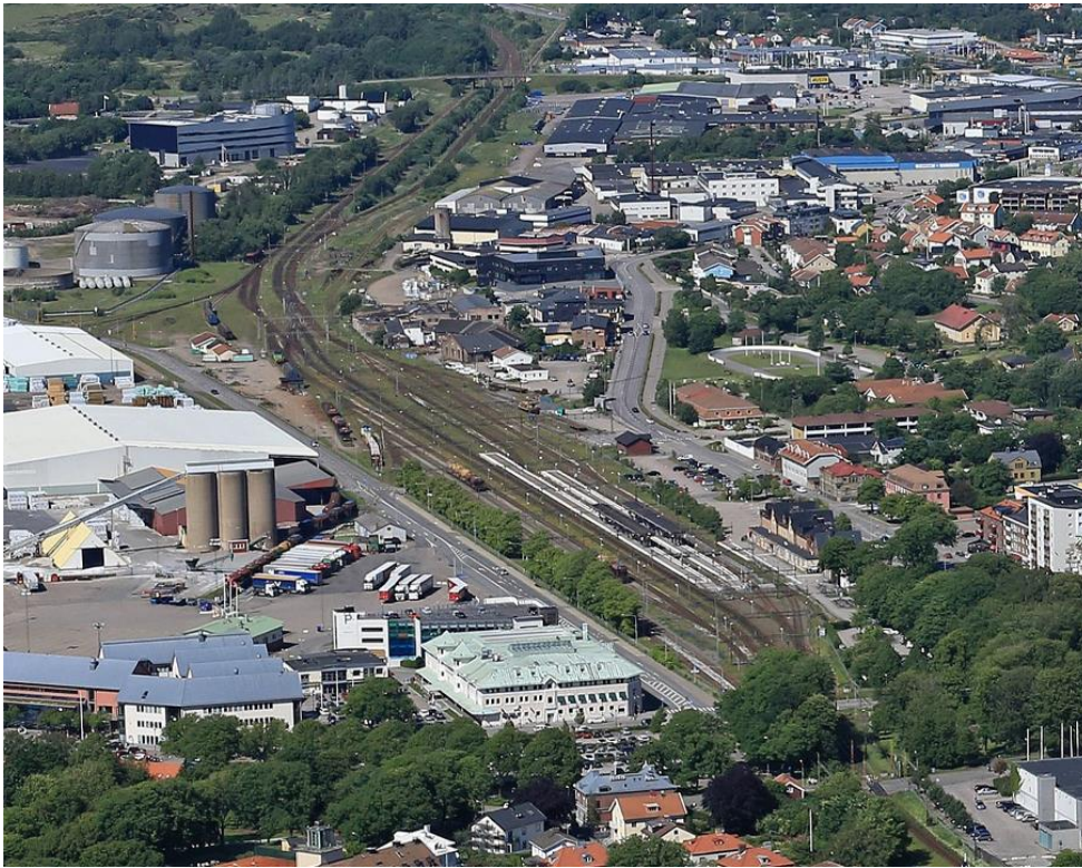
På Sveriges västkust har Implenia fått i uppdrag att planera och förbereda omvandlingen av en järnvägslinje från enkel- till dubbelspår. Från 2025 kommer passagerar- och godståg att köra under Varbergs stad. (Bild: Trafikverket)
